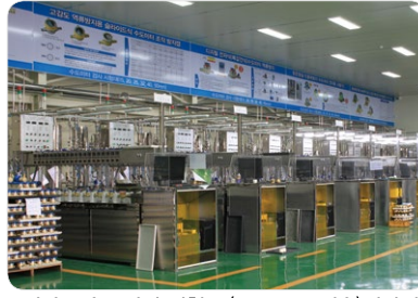
전자동 수도미터 시험1.6(100~200배수)검사대 계량기능공사(15~50mm)
